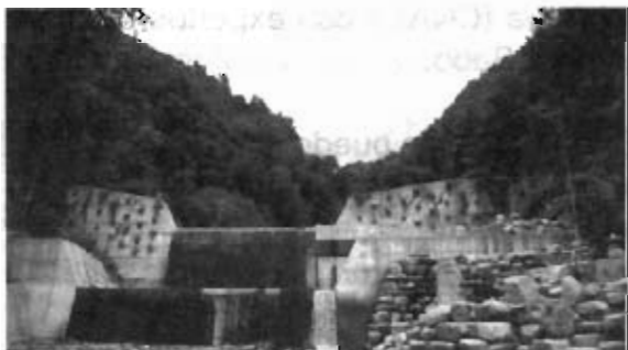
Fotografía 11. Presa Sabo, que sirve para acumular pequeños fragmentos de roca y sedimentos previamente clasificados aguas arriba
