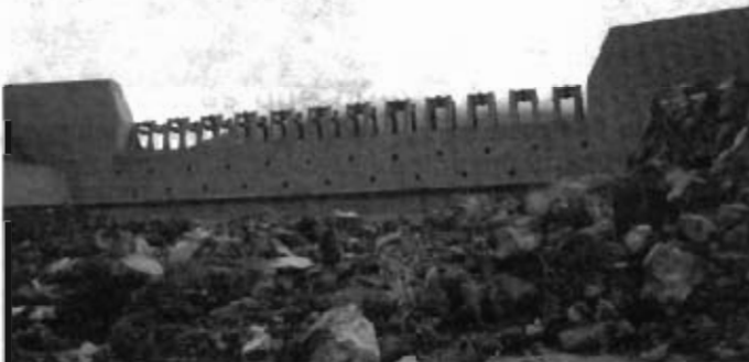
Fotografía 7. Presa cribadora de rejilla vertical con estructura de acero y concreto armado, para detener grandes bloques de roca que viajan dentro de los flujos de lodo
