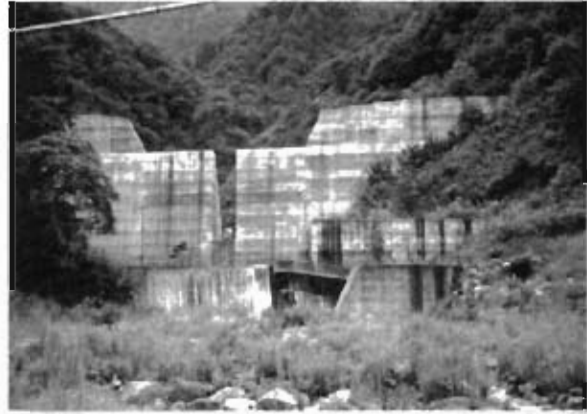
Fotografía 8. Presa cribadora de rejilla vertical construida con concreto armado, cuya función es muy similar a la desempeñada por las estructuras mostradas en las fotografías 6 y 7
