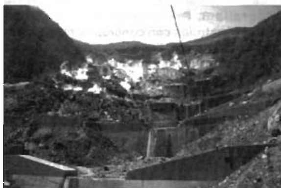
Fotografía 3. Trabajos de retención de sedimentos para evitar la erosión en el lecho y partes laterales de barrancas, con lo que se evita la producción de sedimentos y su adición a los flujos de lodo
