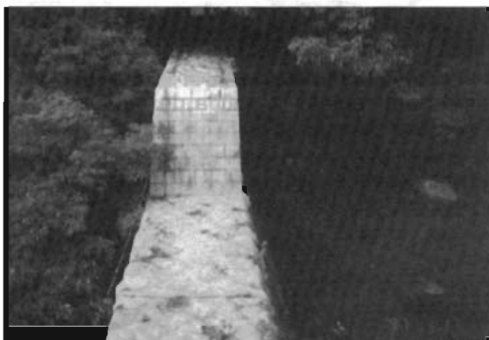
Fotografía 5. Presa baja o reducida, cuya función es consolidar los sedimentos inestables provenientes de aguas arriba
