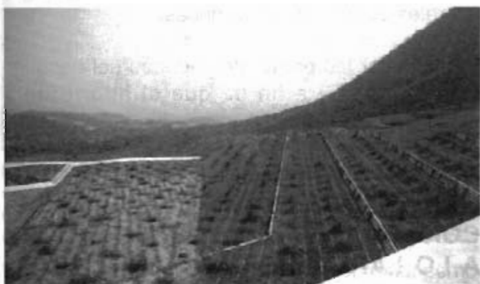
Fotografía 14. Siembra de pastos y arbustos, que servirán para evitar la producción de sedimentos
