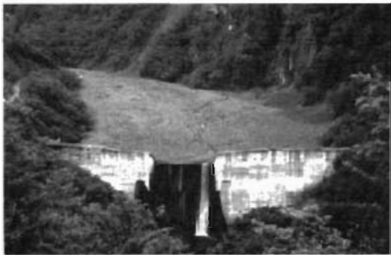
Fotografía 10. Presa de gravedad, que sirve para almacenar rocas y sedimentos previamente separados por otras estructuras aguas arriba de los cauces y barrancas
