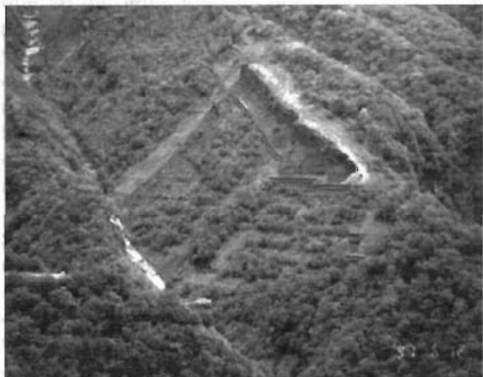
Fotografía 15. Trabajos de reforestación, para evitar la producción de sedimentos y evitar que aumente el poder destructivo de los flujos generados en las laderas de zonas volcánicas
